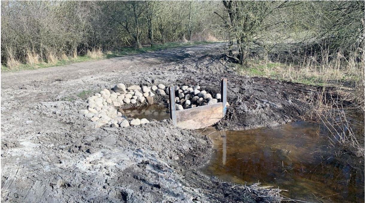
Abb. 5: Stautafel zum Wasserrückhalt in der Moorfläche
