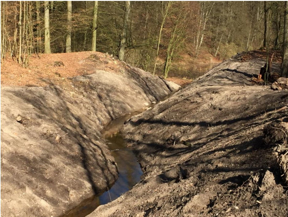
Abb. 3: Ablauf aus der Tiedendiek in Richtung Lankower See im geöffneten Wasserlauf
