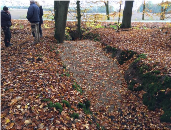
Abb. 2: Sohlschwelle am Auslauf aus dem Drönnewitzer Holz
