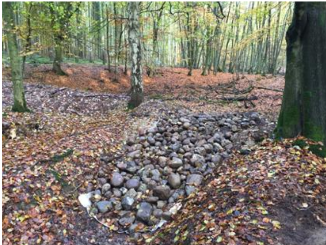
Abb. 3: Bau einer Sohlschwelle im Drönnewitzer Holz (Bauphase)
